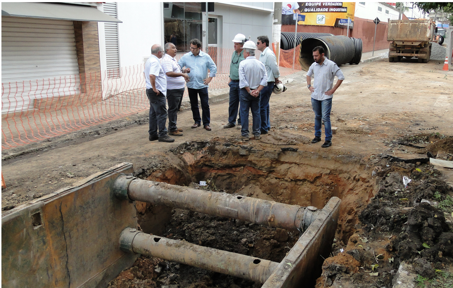
Prefeito Agnaldo Perugini e sua equipe técnica na obra da galeria da Av. João Beraldo
